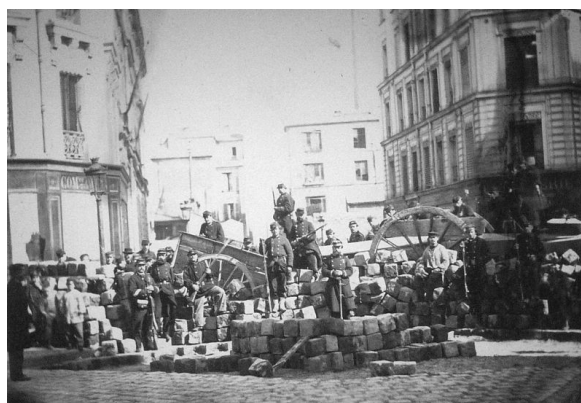
Barricade du passage Raoul
