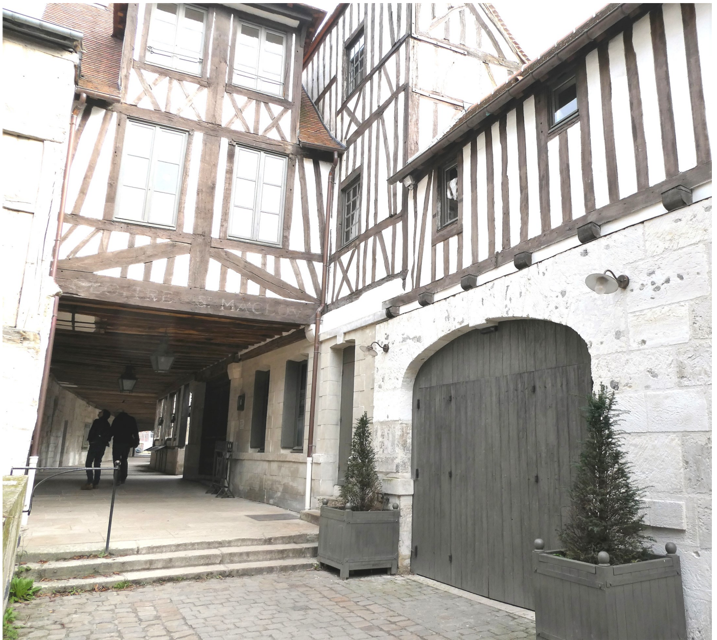
Entrée de l'aître : après le portail de la cour des prêtres, que surplombent les latrines, porte donnant sur l'escalier de l'école et fenêtres du logement des maîtresses. Les deux fenêtres au-dessus du passage étaient celles de la plus grande classe.
